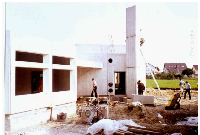
Rohbau des Gemeindezentrums in Buchheim ca. 1972
